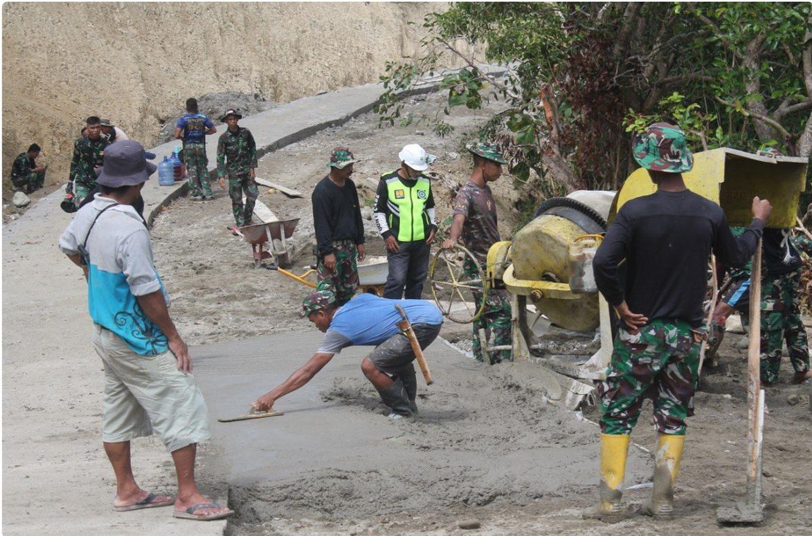
Tim Dinas Pekerjaan Umum yang dipimpin Kepala Bidang Binamarga Aksan S.T didampingi Komandan SSK TMMD Ke-115 Kodim 1401/Majene Kapten Inf Ardam Nyampa, meninjau langsung proses pengerjaan pengecoran jalan sekaligus mengukur ulang hasil pengerjaan dan memastikan apakah sudah sesuai dengan RAB dan Konsumsi Gambaran Kontruksi dari Dinas PU dalam hasil pengerjaannya.
